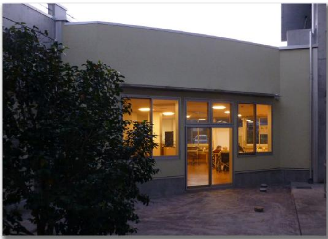
増築工事で完成した『大ホール』
